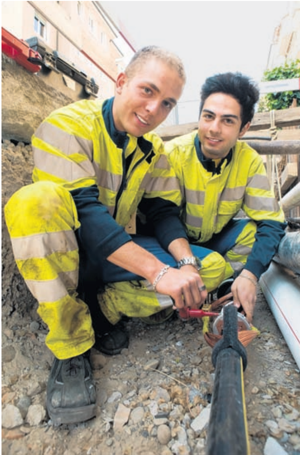
Unter dem Boden. Leander Bär und Micael Pires verlegen neue Kabel. Foto Roland Schmid
